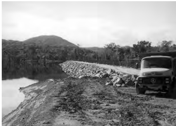
Figura 4. Um dos segmentos da hidrelétrica de Jatapu.
