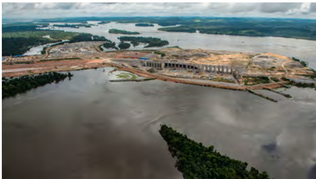
Figura 1. A represa de Belo Monte em construção sobre o rio Xingu, afluente do Amazonas, em 2015. Foto: F. Nascimento/Greenpeace
