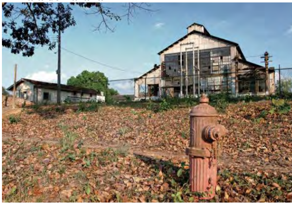
Casarão Industrial de Fordlandia
