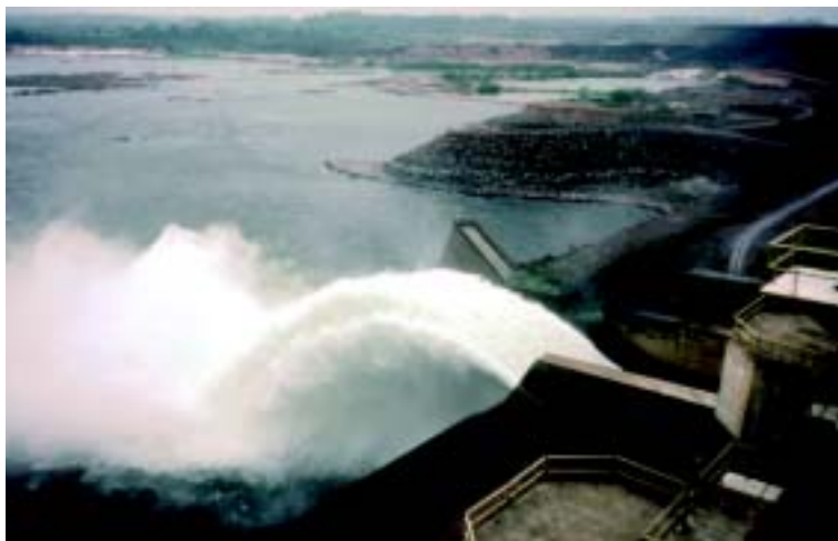
Figura 2. Em forma de salto de esqui, o vertedouro da hidrelétrica de Tucuruí oxigena a água mas simultaneamente libera metano
