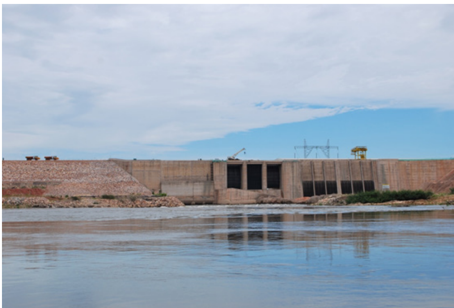
Figura 7. A barragem da UHE Sinop, vista do lado a montante com o rio no seu nível natural sem barramento. As três comportas, e, a sua direita, os dois conjuntos de três stop-logs nas entradas das duas turbinas, são todas localizadas a profundidades que tirariam água abaixo do nível da termoclina que divide a coluna d'água em um reservatório estratificado, geralmente a 2-10 m de profundidade. A água na profundidade das entradas na UHE-Sinop teria teor elevada de metano, que seria lançado ao ar quando a água emerge em um ambiente com pressão igual a apenas uma atmosfera, abaixo da barragem. Foto: P.M. Fearnside, 13 de novembro de 2018.
