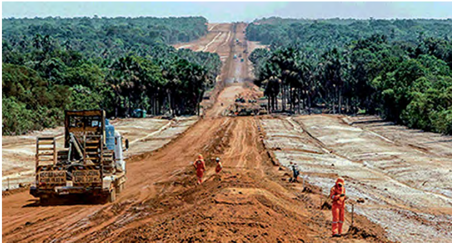
Figura 1. O Santarém-Cuiabá (BR-163), destinado à reconstrução para transportar a soja de Mato Grosso para os portos do rio Amazonas (Fearnside, 2007), é um importante corredor para desmatamento e extração de madeira. Construir ou melhorar uma estrada desencadeia a migração da população com impactos de longo alcance no meio ambiente e na população tradicional. Foto: Pulsar images/Alamy stock photo
