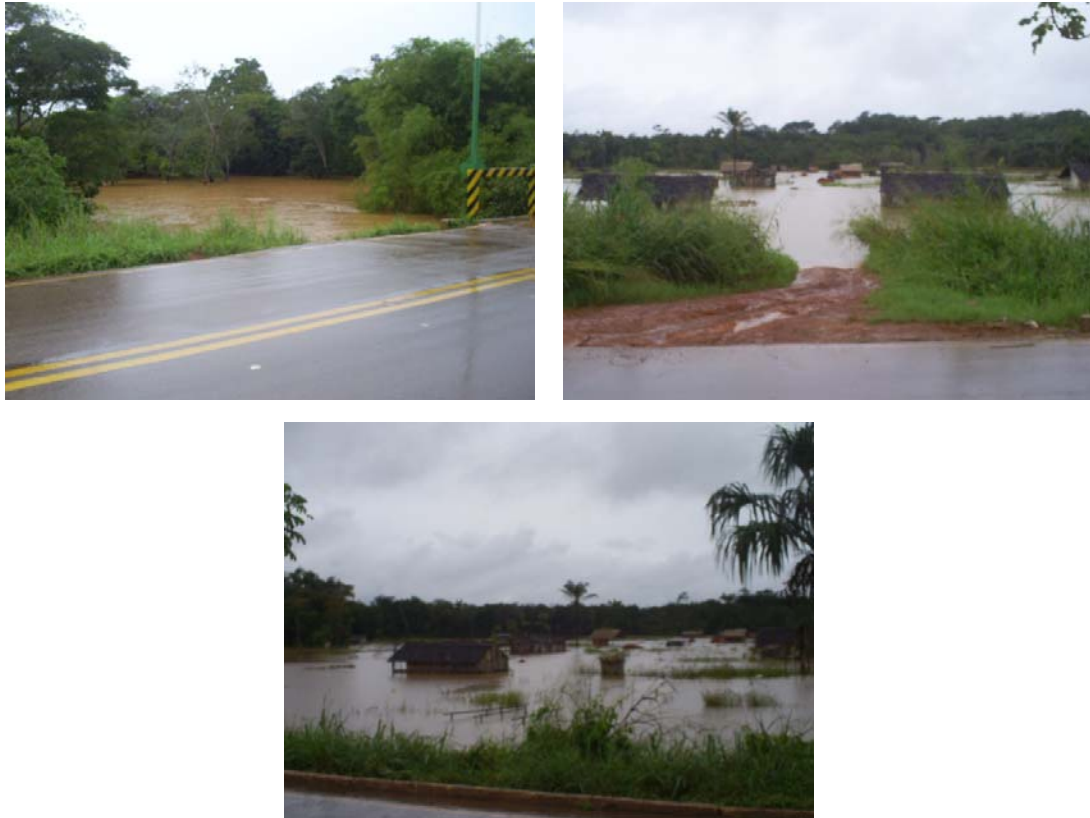
Figura 10 – Ponte 07 – Igarapé Panelas
