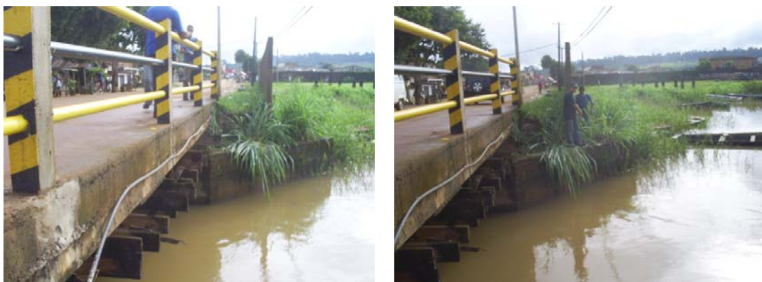
Figura 04 – Ponte 01 – Igarapé Altamira
